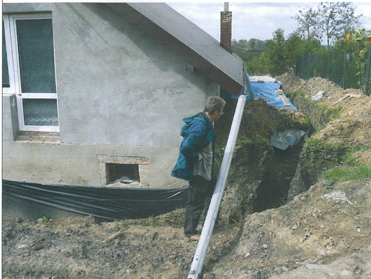
Fot. 5. Wykopy drenażowe wokół budynku mieszkalnego przy ul. A Mickiewicza 116A.
