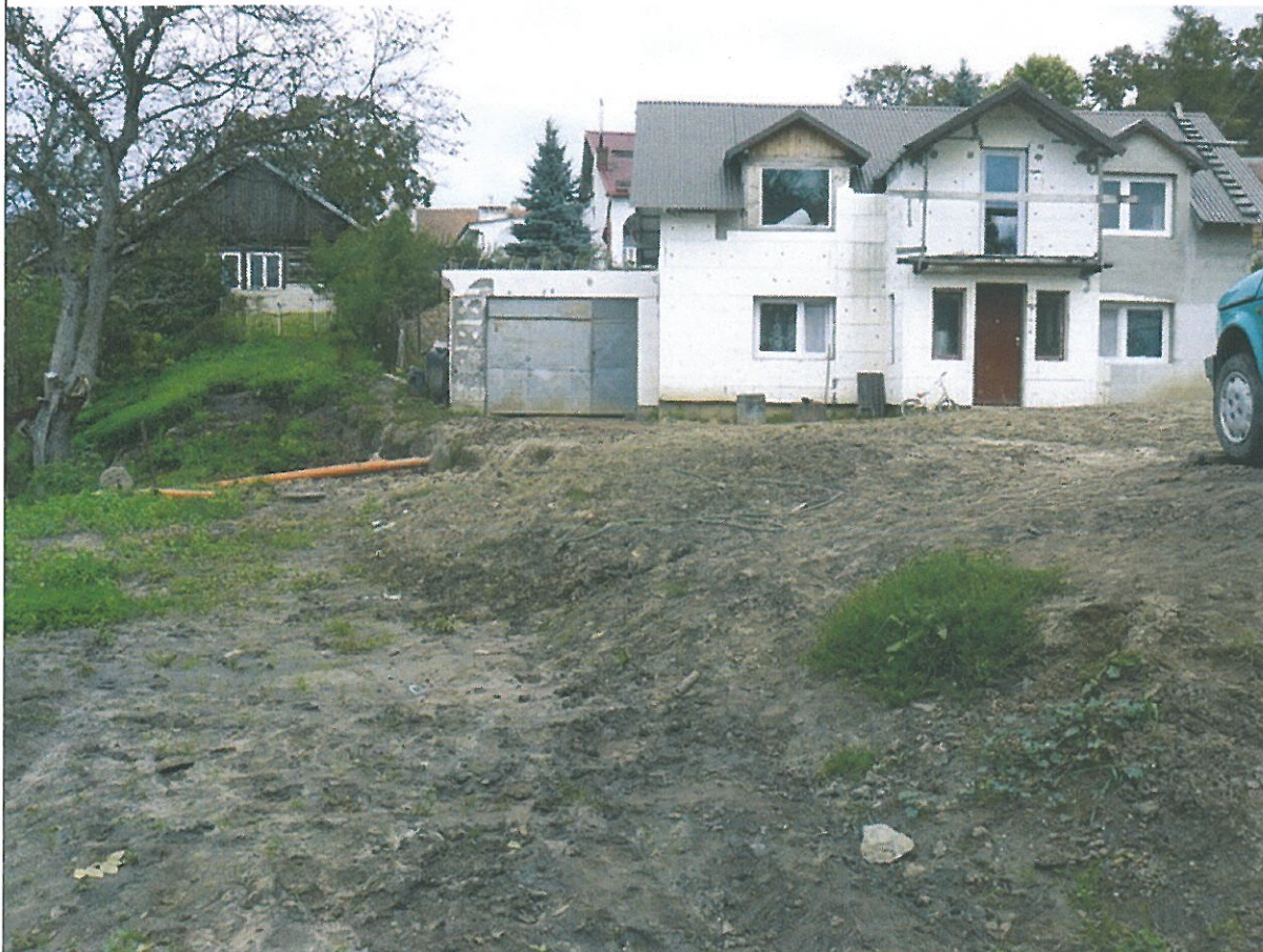
Fot. 6. Częściowo zniwelowana przez właściciela posesji nisza główna osuwiska wraz z budynkiem mieszkalnym przy ul. A. Mickiewicza 116A.
